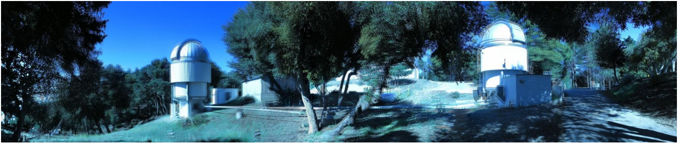
Télescopes Sud 1 et Sud 2, séparés de 34m
