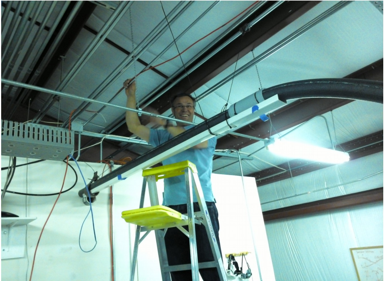
Passage de nos fibres optiques à travers la cloison par François
